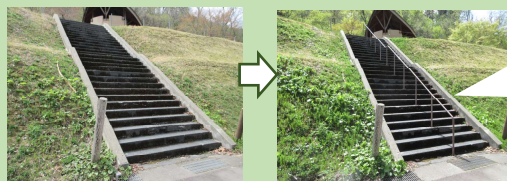
トイレ付近の階段の手すり設置
