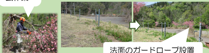
折れた枝の撤去作業
